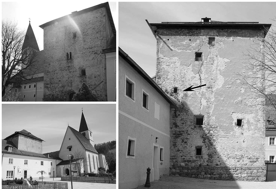
Obr. 10. Bischofshofen (Rakousko, Salcbursko). Areál bývalého biskupského dvora, věž „Kastenturm“ a její prostorový vztah ke kostelu sv. Maxmiliána. Šipka označuje zazděný vstup na východní straně věže. Fig. 10. Bischofshofen (Austria, Land Salzburg). The grounds of the former bishop's estate, the 'Kastenturm' tower and its spatial relationship to the Church of St Maximilian. The arrow indicates the bricked-in entrance on the east side of the tower.
